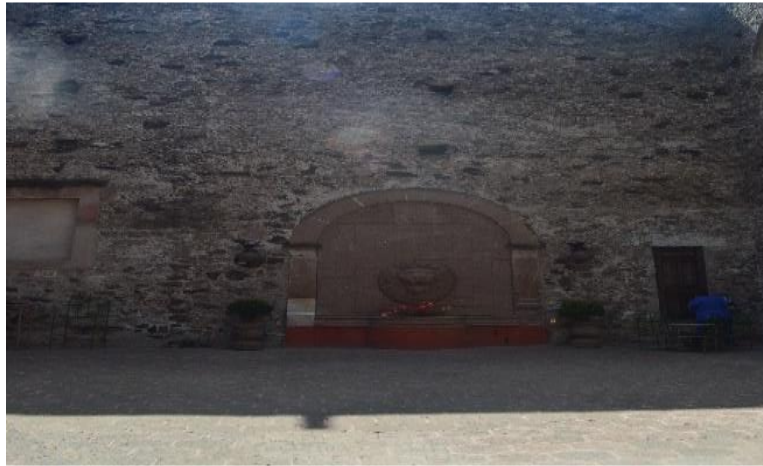
Figura 6 Fachada izquierda de “La Casa del Diezmo” donde se realizará la evaluación de iluminación
