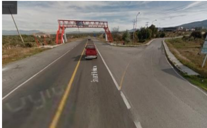
Figura 2 Parada de autobús e intersección de la carretera Federal 45 Portezuelo-Palmillas con entrada a la comunidad del Saucillo
