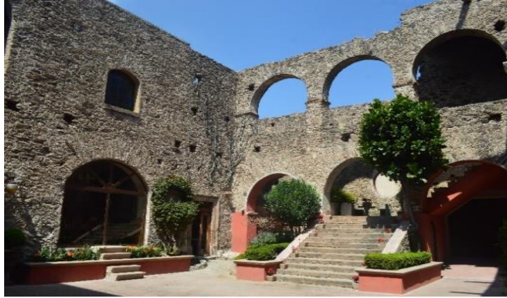
Figura 1 Patio central de “La Casa del Diezmo”
