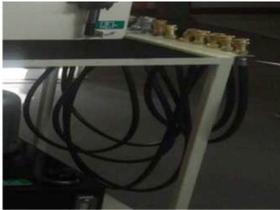
Figura 19.5 Instalación de almacén de mangueras
