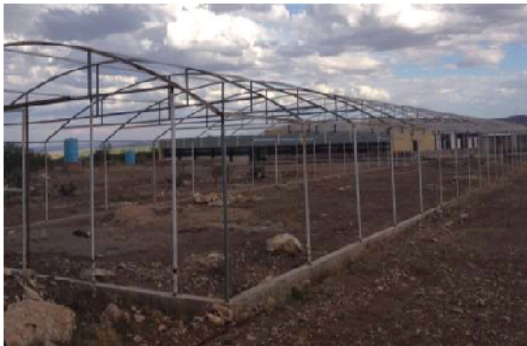
Figura 12 Estructura de invernadero UPZ
