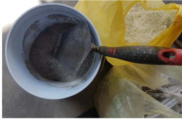
Figura 4 Mezcla de cemento-cal-arena
