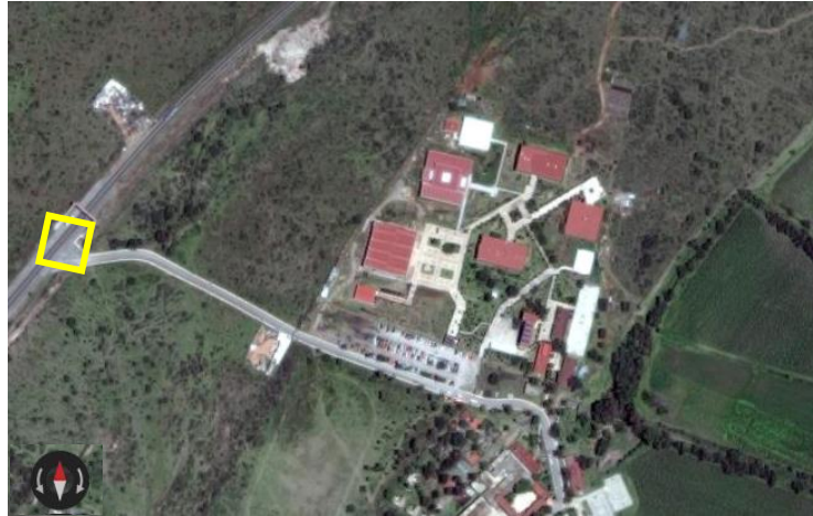
Figura 2 Ubicación del edificio a analizar
