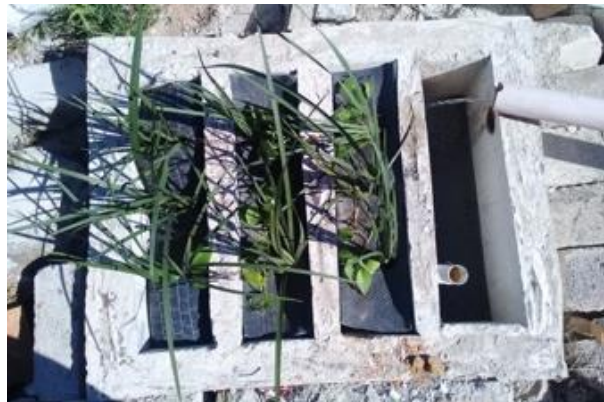
Figura 1 Módulo de saneamiento
