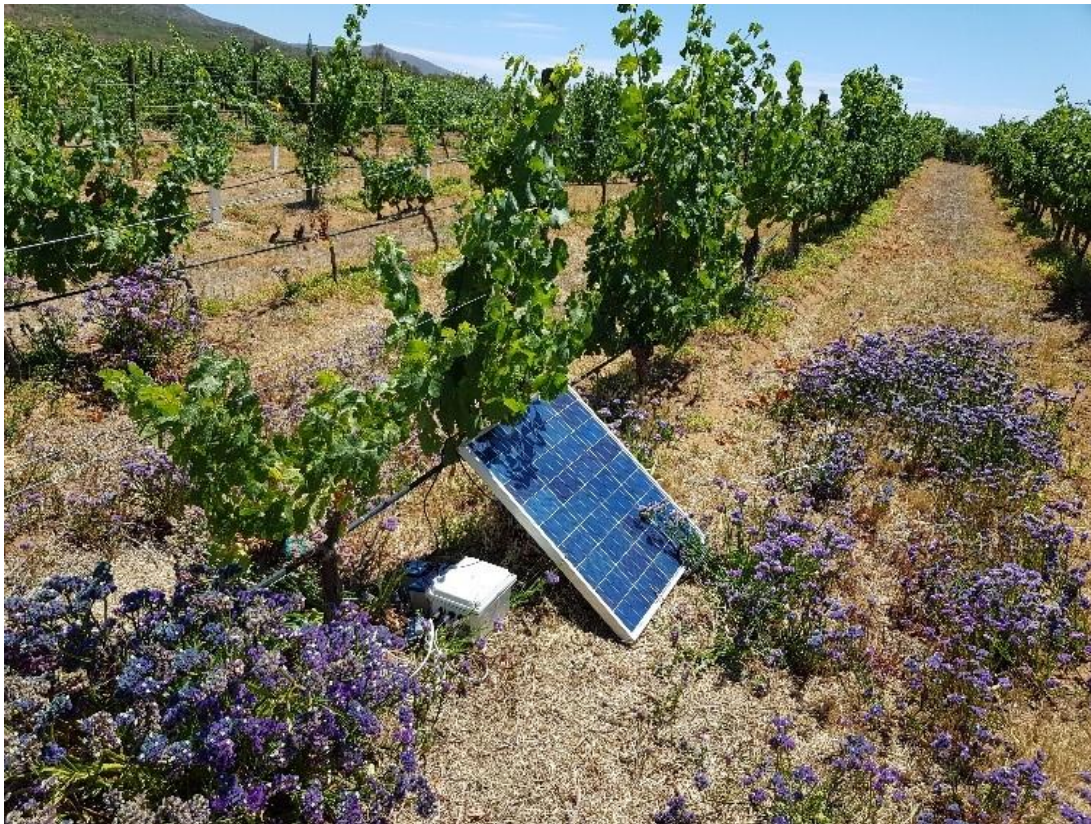
Figura 9 Nodo de sensores con su respectivo panel solar. Fuente: autoría propia
