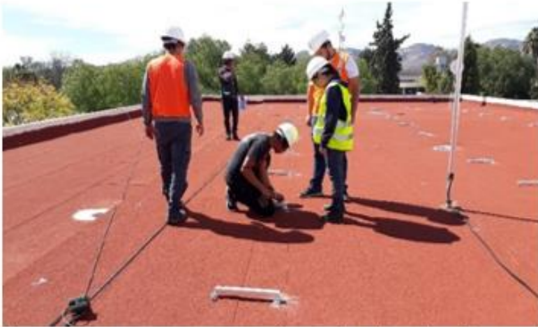
Ilustración 1. Trazo para colocación de rieles de estructura metálica. "Elaboración propia"
