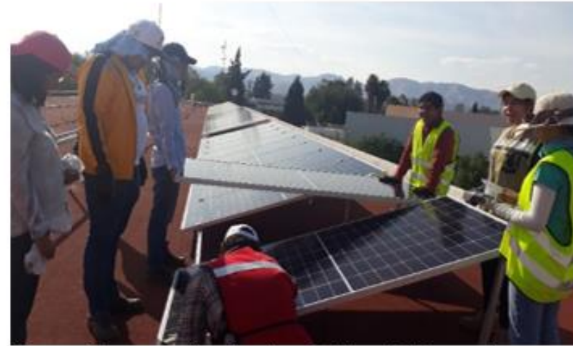
Ilustración 3. Instalación de módulos. "Elaboración propia"
