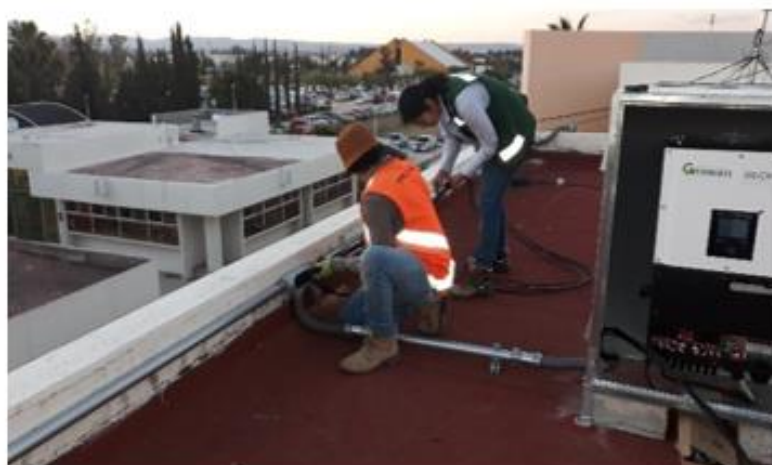
Ilustración 6. Instalación de cable e inversores. "Elaboración propia"
