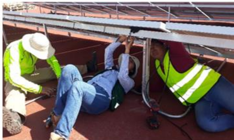
Ilustración 5. Conexión de módulos. "Elaboración propia"
