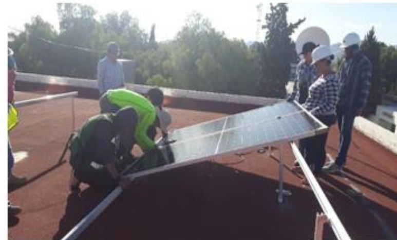
Ilustración 4. Alineación de módulos. "Elaboración propia"
