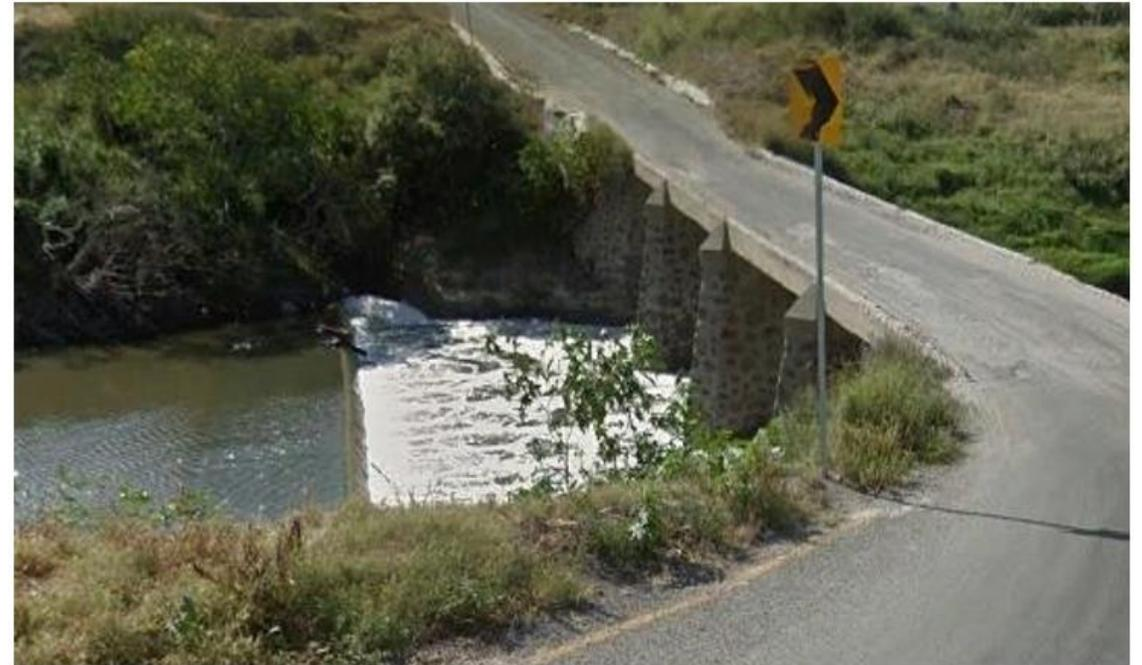
Se trata de un puente con un claro de 22 m, un ancho de cubierta de 3.5 m, con 3 pilas ovaladas separadas a eje 6.5 m y estribos con pared recta. (Imagen de Google Earth)
