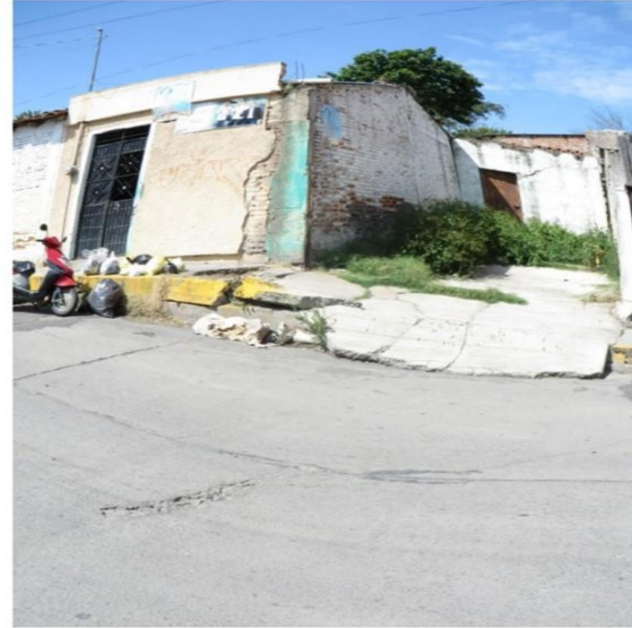
Figura 5 Casas dañadas en Cd. Guzmán (Fotografía del archivo de Maciel-Flores).
