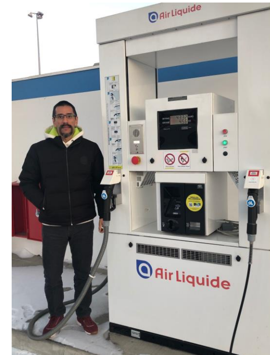
Estación de repostaje de hidrógeno (hidrogenera) (Düsseldorf, Alemania, 2021)
