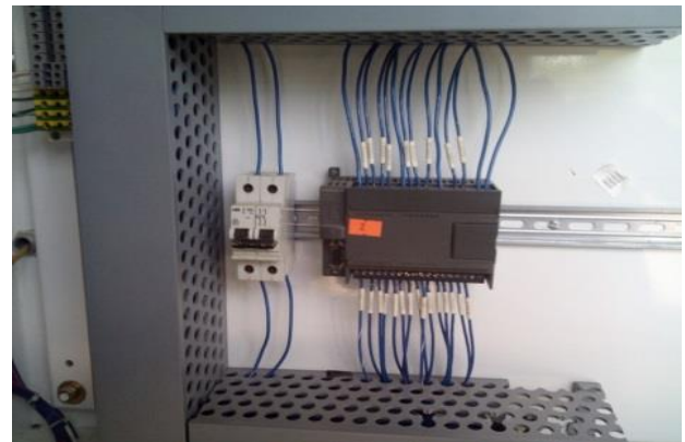
Figura 1 Instalación del Nuevo PLC S7-1200
