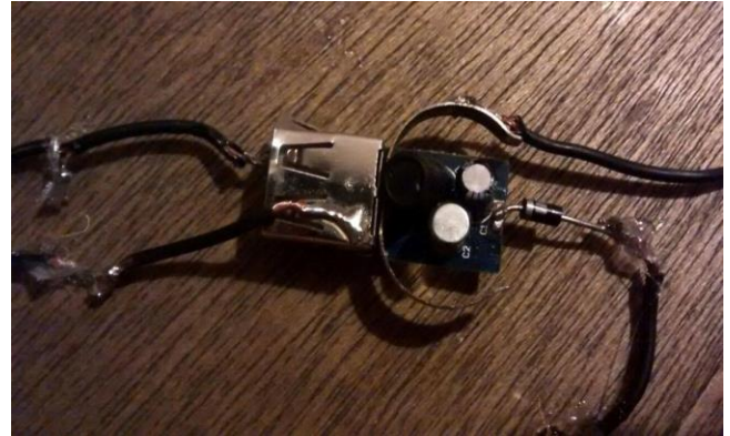
Figura 3 Reductor de voltaje conectado a la batería y al panel solar
