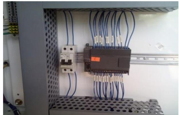
**Figura 1** Instalación del Nuevo PLC S7-1200
