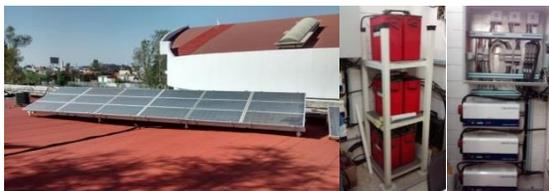
Figura 1 Sistema fotovoltaico autónomo.
