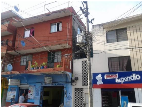
Figura 1 Cableado eléctrico en México.
