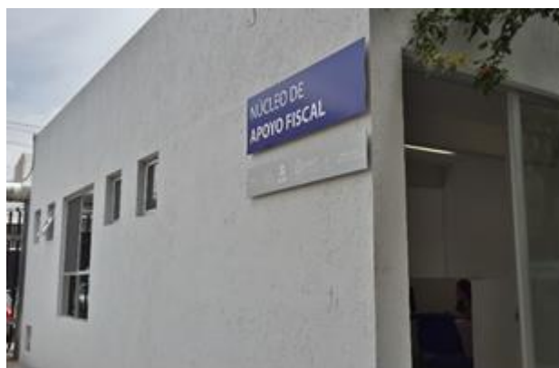
Figura 1 Instalaciones del Núcleo de Apoyo Fiscal (NAF) en la UASLP
