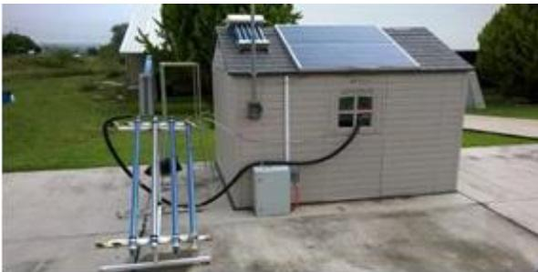
**Figura 1** Sistema del colector solar de tubos evacuados
