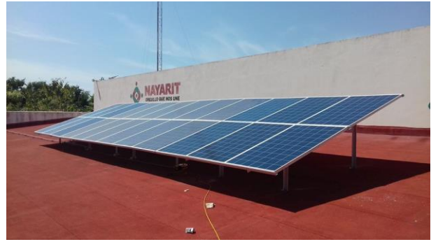
Figura 5 SFV interconectado a la red en la UTBB
