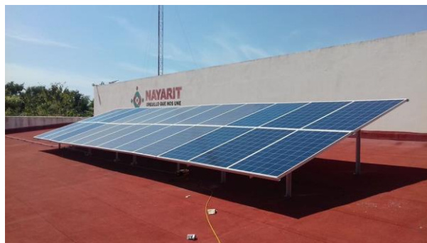
Figura 5 SFV interconectado a la red en la UTBB
