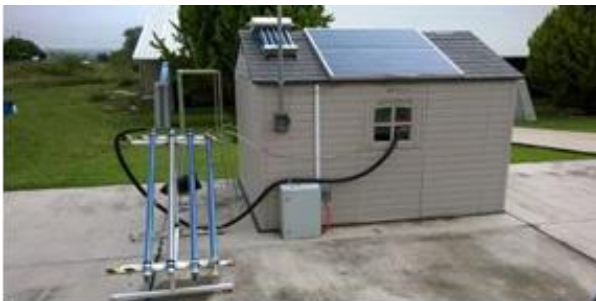
Figura 1 Sistema del colector solar de tubos evacuados
