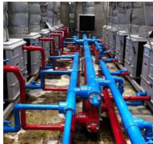
**Figura 2** Distribución de las bombas de calor
