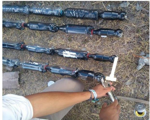
**Figura 9** Cama absorbedora con las botellas instaladas.
