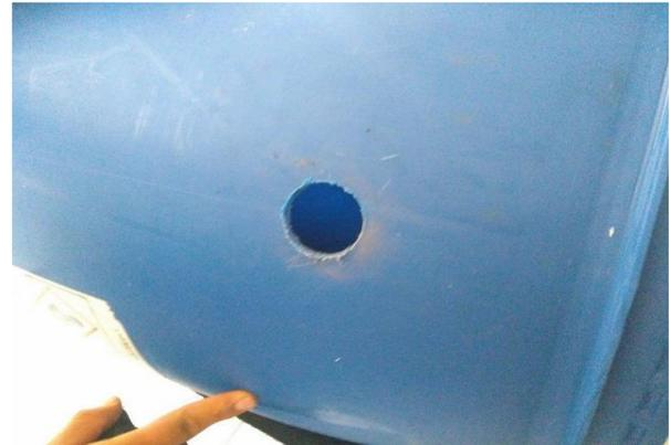
**Figura 10** Perforación en el tanque interior para las conexiones de la tubería
