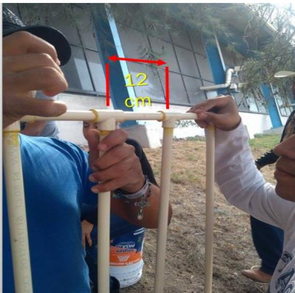
**Figura 5** Se pegaron todos los ramales con sus respectivas tees y codos (como se muestra)
