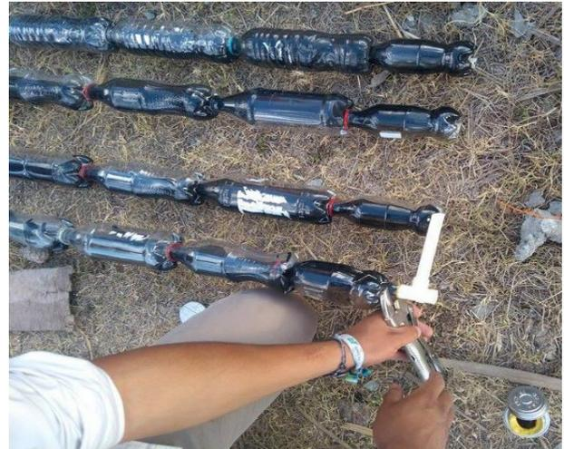
**Figura 9** Cama absorbedora con las botellas instaladas.
