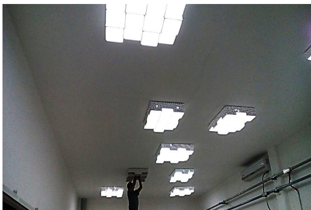
Figura 13 Instalación de luminarias importadas desde China en México
