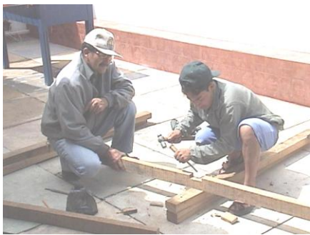
Figura 2 Preparación de Armazón de madera (tipo caballete)
