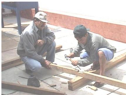
**Figura 2** Preparación de Armazón de madera (tipo caballete)
