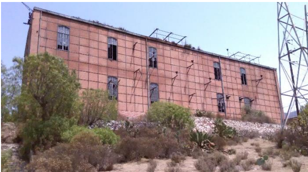
Figura 5 Subestación Eléctrica en Bo. San Guillermo
