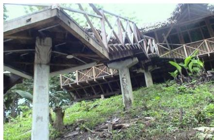
Para la union de los elementos se han utilizado pernos y planchetas de fierro (1/16"), asegurando de este modo el correcto anclaje de toda la estructura que esta suspendida del suelo salvando los desniveles del sitio de intervencion y protegiendo los materiales de los agentes naturales.
