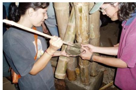
El último paso es el relleno o embutido de concreto en forma de morteros de cemento que son introducidos a las juntas donde existe empernaje a fin de reforzar las mismas y poder ajustar los pernos sin dañar o quebrar los rollizos de bambú tacuara.
