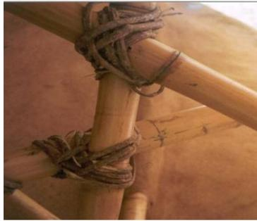
Fijación por simple amarre, es el sistema más rudimentario pero aún vigente en las etnias que utilizan el bambú en la construcción, utilizando para ello cuerdas, alambres, sunchos metálicos, plásticos e inclusive lias vegetales para poder amarrar la unión de elementos y construir estructuras simples como bardas y otras utilidades domésticas.
