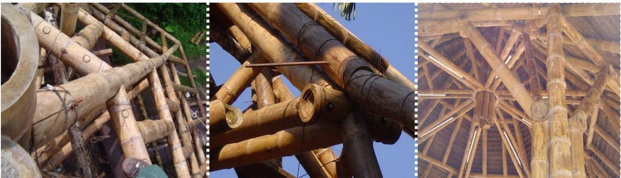
Uniones, para el ensamble de los rollizos es necesario contar con un diseño definido para poder elaborar las piezas de corte y union que son ensambladas por simple amarre con cuerdas, alambre en incluso lias vegetales como medio provicional hasta fijar los elementos a traves de fijadores, platinas metalicas y pernos que son reforzados por el embutido de mortero de cemento para evitar el rasgado del material estructural (bambú).
