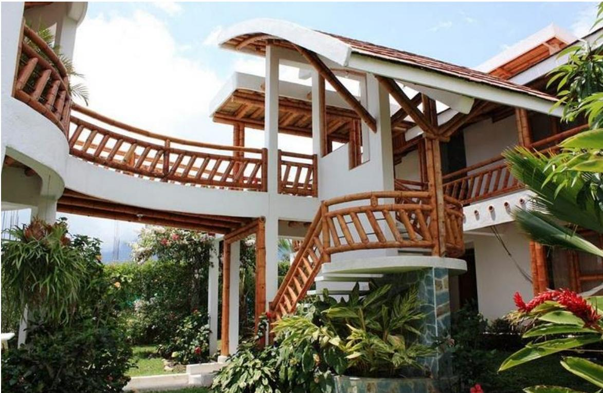
Vivienda Unifamiliar de características constructivas mixtas, empleándose una estructura portante de Hormigón Armado para ser rellenado en secciones modulares por elementos en bambú como ser; muros, barandas, losas, cielos y cubiertas, definiendo muy ricamente el lenguaje arquitectónico y calidad de la vivienda.
