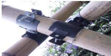
Complementos metálicos, es un sistema de reciente difusión a través del empleo de abrazaderas metálicas de diferentes tamaños a fin de poder sujetar los elementos sin perforar los rollizos y debilitarlos.
