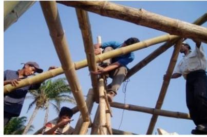
Se procede a armar la estructura en función del diseño y tipo de corte que permita el maclaje de las piezas, utilizando para esto cuerdas o alambres como fijación provisional o andamiajes hasta establecer las definitivas.
