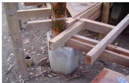
En ambos tipos las fundaciones son de H° A° para proteger al bambu del contacto con el suelo, la humedad e insectos por ser propenso a deteriorarse con mayor facilidad si el material es expuesto a estos agentes.
