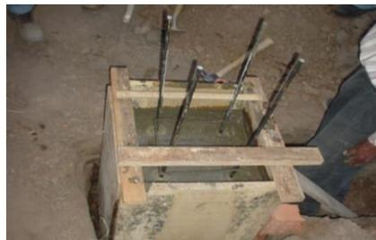
En el Hotel motivo de analisis se han empleado unicamente las fundaciones de tipo aislado que soportan las columnas de bambu, utilizando anclajes de fierro corrugado que se prolongan desde la fundacion en si hasta la columna de bambu que sera embutida de un mortero para unir ambos elementos.
