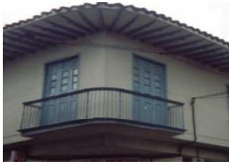
El más popular de todos, quizá por su accesibilidad y por ser el primero. Este tipo de bahereque terminado con revoque de mortero de tierra sobre esterilla o latas de guadua, tuvo como alternativas los muros macizos y los muros huecos, ambos con la misma estructura.
