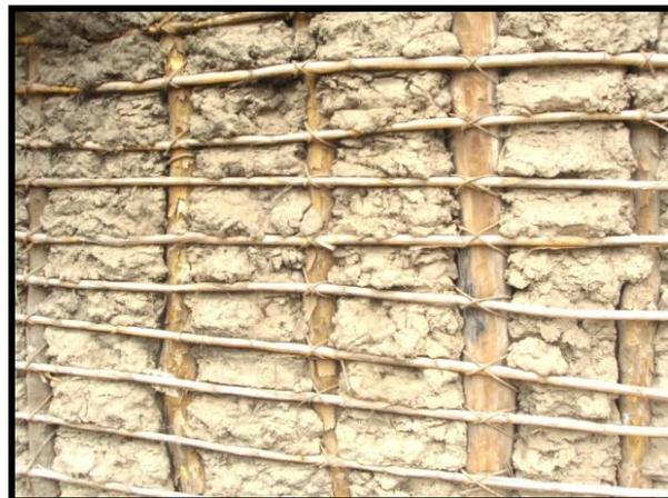
En este ejemplo no se puede ver de manera completa la estructura de bambú por el revoque densamente aplicado en la superficie, que sin embargo ya muestra los efectos del desgaste por acción de las lluvias y falta de protección.
