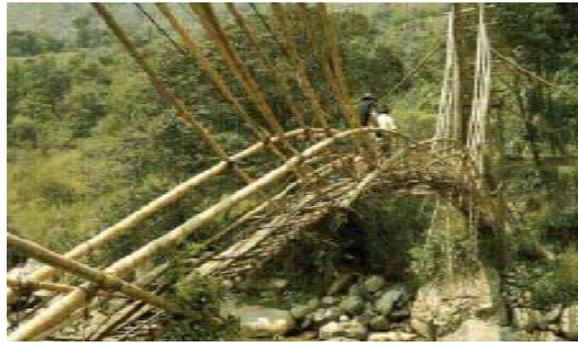
Basados en la misma tecnología de aplicación arquitectónica se han conseguido la construcción de puentes peatonales que van desde los 5 a 70 metros de luz, tal es el caso del puente que se muestra en la figura que alcanza esta longitud con apoyos a tracción y compresión completando la estructura.
