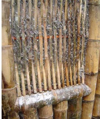
Los paneles bahereque son construidos utilizando el bambu charqueado (rallado) generando un tejido de distintas formas que sirve de estructura portante complementada por malla y hojas de paja o palma para completar el elemento con revoques de cemento y alternativamente revestimientos de bambu charqueado tejido o en forma de rollizos, consiguiendo muros livianos y altamente resistentes inclusive a movimientos sismicos por su flexibilidad.
