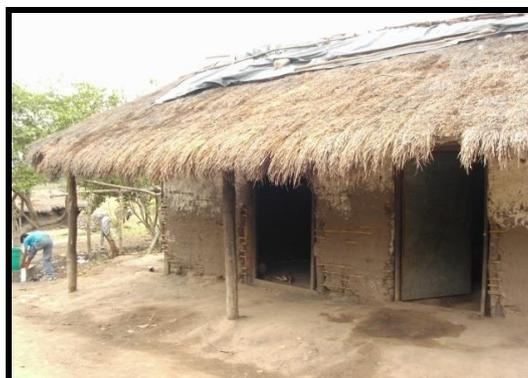
En las comunidades guaraníes Canadillas, Taperillas y otras se puede observar la utilización del bambú de manera más técnica y en forma de “paderes” muros tipo bahereque que están contruidos de manera combinada con troncos de madera y caña hueca, sistema constructivo heredado y completamente artesanal.
