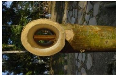
Se debe fijar los elementos a través de varillas de acero utilizándolos como fijadores metálicos para las distintas combinaciones que puede requerir la estructura atravesando las secciones y tensionando las juntas por acción directa del empernaje.
