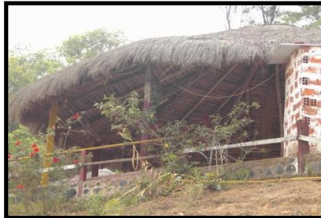
En esta cabaña se observa la utilización de bambú para la construcción de la estructura portante, que es combinada con madera para completar el diseño.
