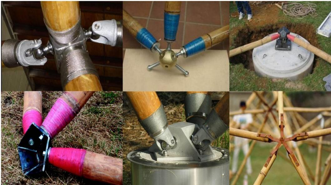
Como se puede observar las uniones o nodos son realizados de diferentes formas usándose de preferencia complementos metálicos que articulan las barras de las mallas espaciales y poder transmitir de esta forma los esfuerzos de una estructura.
