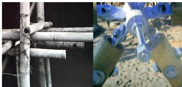
La complejidad de las estructuras de tacuara están condicionadas por los elementos que las componen: barras, uniones y diseño.
