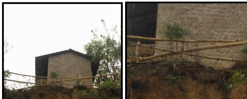
En el ejemplo se puede observar bardas improvisadas con bambú que muestra la utilización del bambú en la ciudad y poblaciones aledañas. Es evidente la combinación del bambú, madera y caña hueca para la construcción improvisada de espacios de uso doméstico y diversos.
