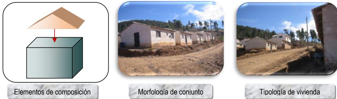
Los materiales de construcción que han sido implementados en las mismas son los bloques de cemento en los muros, las placas onduladas Duralit en las cubiertas y el piso cemento; la edificación ha sido construida sin cimentación, por lo tanto no se tiene opción de crecimiento.
